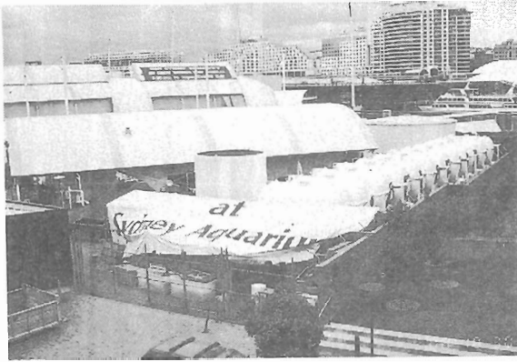
シドニー水族館の海水処理施設
